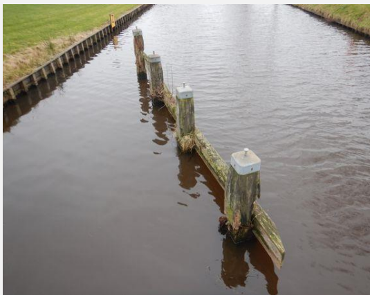
Remming- en geleidewerk - Paal
