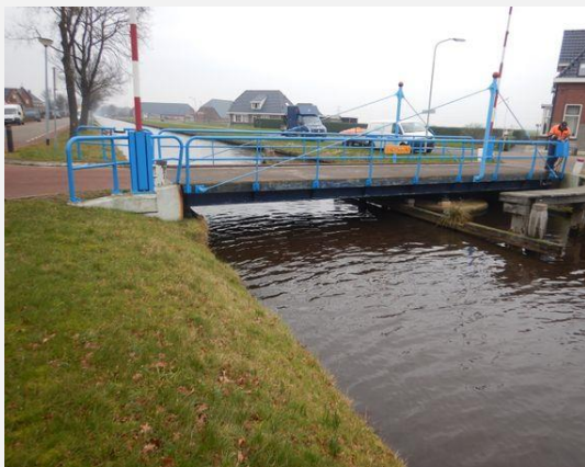
Talud - Talud, Algemeen
