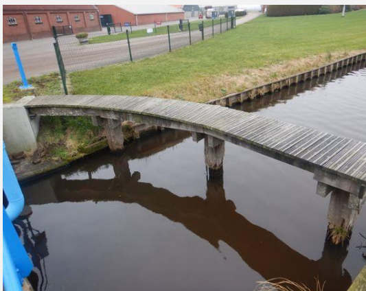
Loopbrug - Loopbrug, Algemeen
