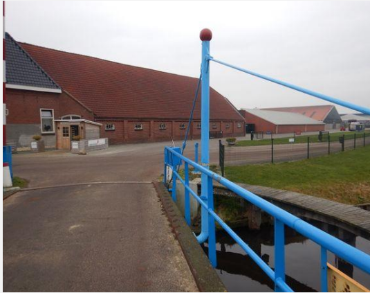
Hoofddraagconstructie - Hanger (boogbrug)
