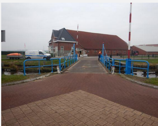
Verharding wegtype 4 (licht belast) - Elementenverharding
