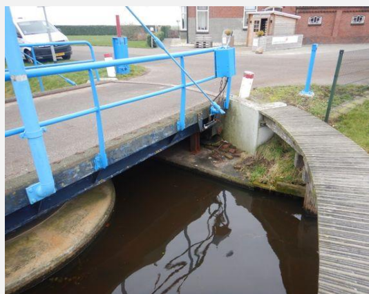
Fundering - Fundatie (Onderdeel niet zichtbaar / niet inspecteerbaar)
