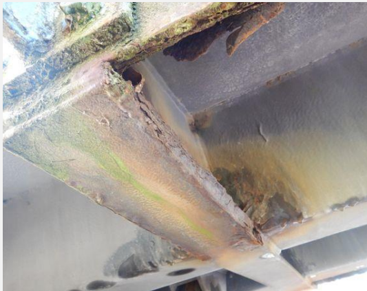
Hoofddraagconstructie - Dwarsdrager
