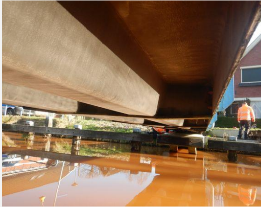
Hoofddraagconstructie - Langsligger
