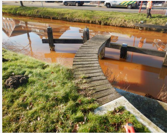
Loopbrug - Loopbrug, Algemeen
