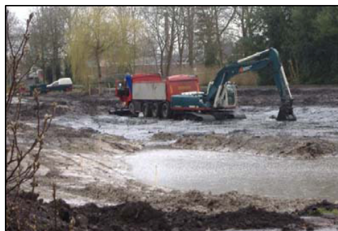
Afbeelding 1.3 Ontgraving waterbodem
